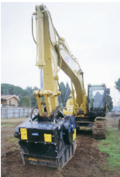
图2: MB-Meccanica Breganzese的破碎铲斗BF 90.3型正装配在一台25吨的Cat 320 CS挖掘机上现场作业。
